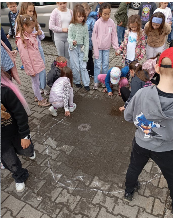
Obr. 14: Prepádnutý chodník na Ulici Struhy
