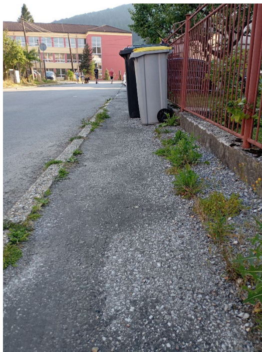
Obr. 13: Prepádnutý chodník a kanálový poklop na ulici 1. mája
