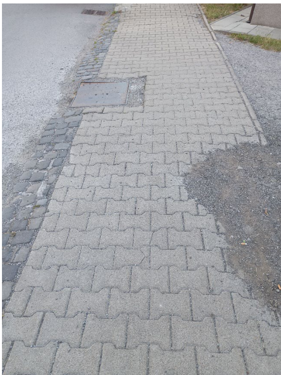
Obr. 13: Prepádnutý chodník a kanálový poklop na ulici 1. mája
